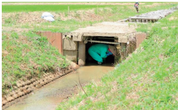
用水路の橋の下に避難する住民
